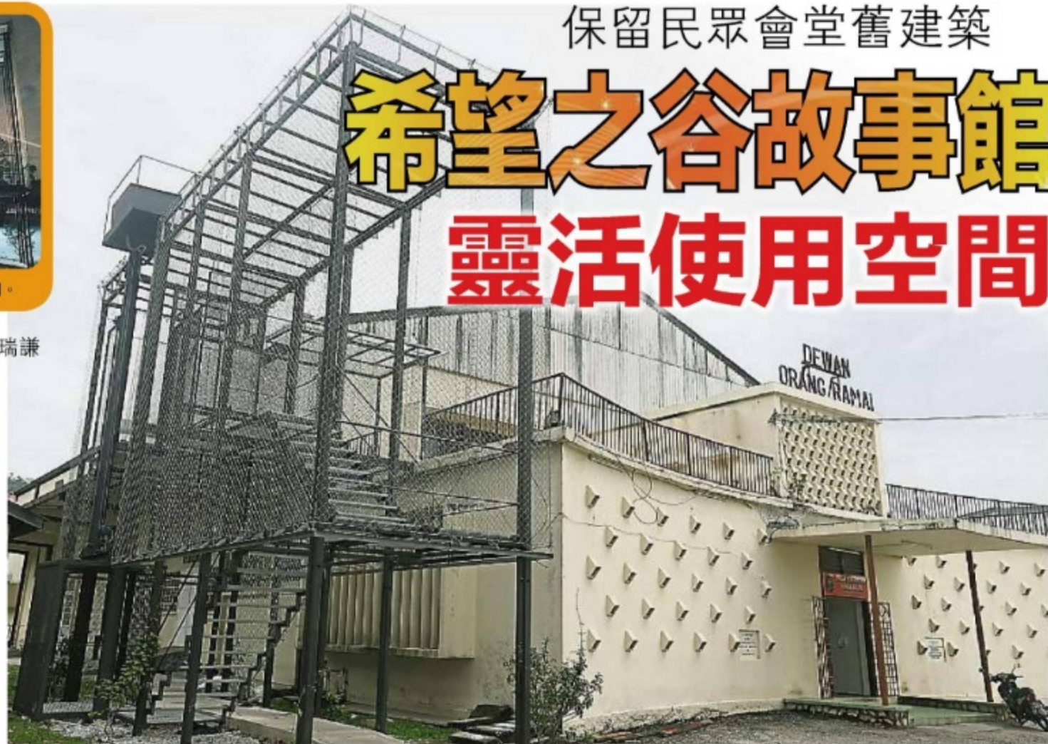
▲底部铺上一层碎片，柱子则是支撑阁楼的架构，免于撬开地板打地桩。
