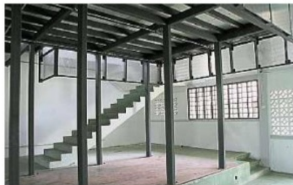
▲底部铺上一层碎片，柱子则是支撑阁楼的架构，免于撬开地板打地桩。
